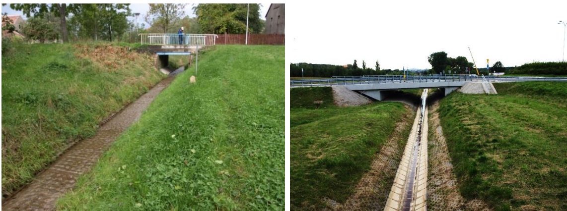
Abb. 14. Künstliches Substrat am Grund eines Fließgewässers – perforierte Betonplatten (links) und Vollbetonplatten (rechts)
