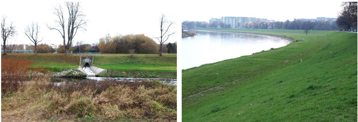
Abb. 32. Beispiele für anthropogene Bauwerke, die das Fließgewässertal einschränken – Hochwasserschutzdeiche
