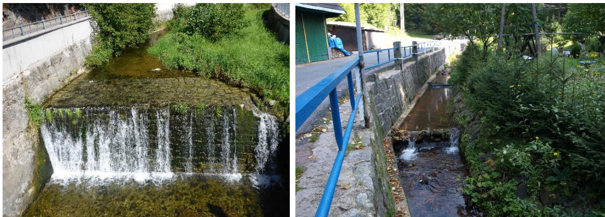
Abb. 24. Querbauwerk: Wasserschwelle (links), Wasserschwellenkaskaden (rechts)
