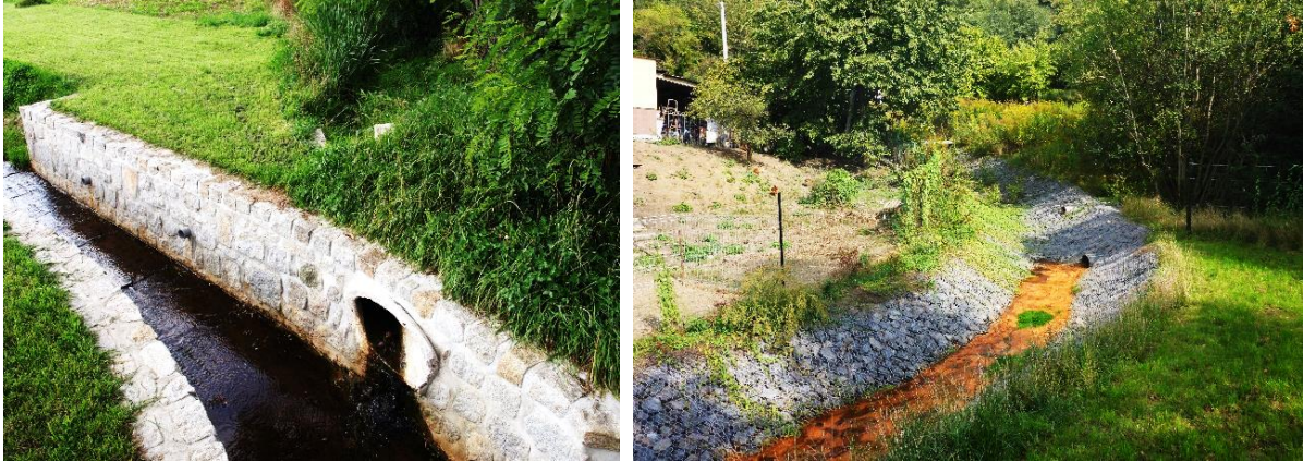
Abb. 25. Beispiele für Einleitungsstellen unmittelbar in ein Fließgewässerbett
